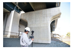
AIひび割れ解析ソリューション
