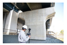
AIひび割れ解析ソリューション
