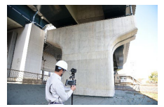
AIひび割れ解析ソリューション
