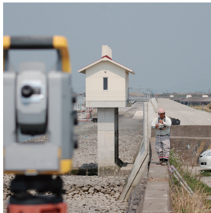
有明川にそそぐ、矢部川のロボティック横断測量の様子
