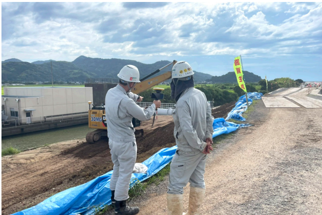
▲現場で SiteVision を見せながら作業の説明をされる磯崎部長
