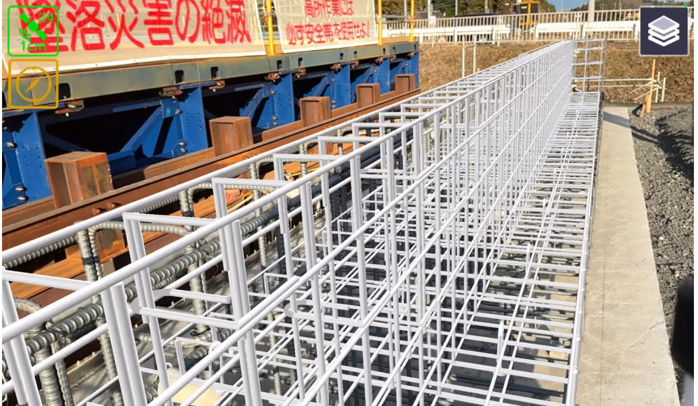
▲ SiteVisionによる現場の配筋確認
