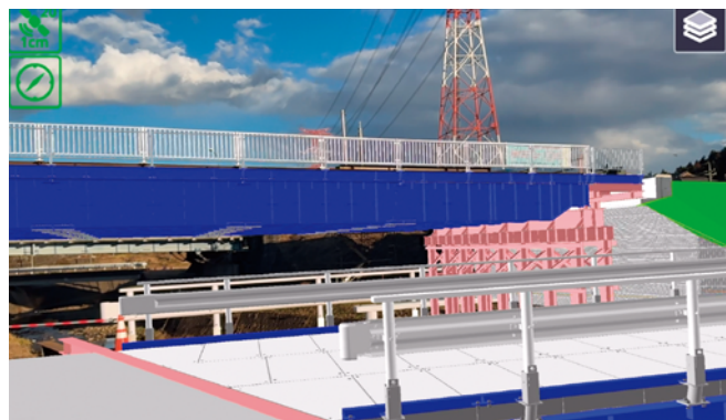
▲ 橋の架け替え工事にSiteVisionを使用
